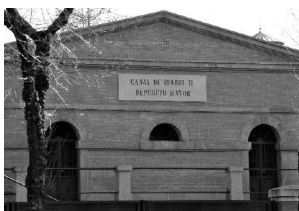
Segundo Depósito del Canal de Isabel II
