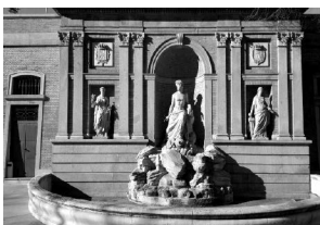
Primer Depósito del Canal de Isabel II
