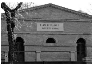
Segundo Depósito del Canal de Isabel II
